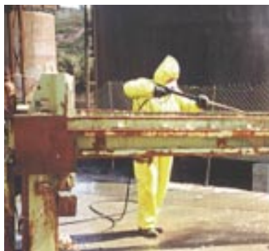
Filter presse : décontamination du châssis.
